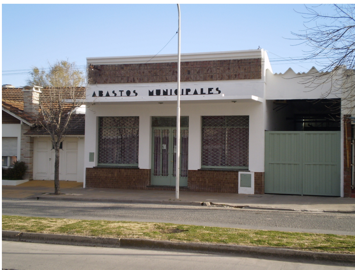
Edificio actual de “Abasto Municipales” en la localidad cabecera
